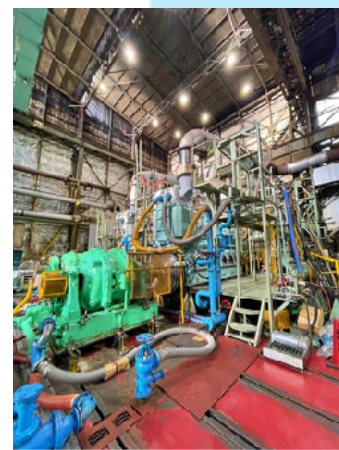
主機の陸上公試運転
