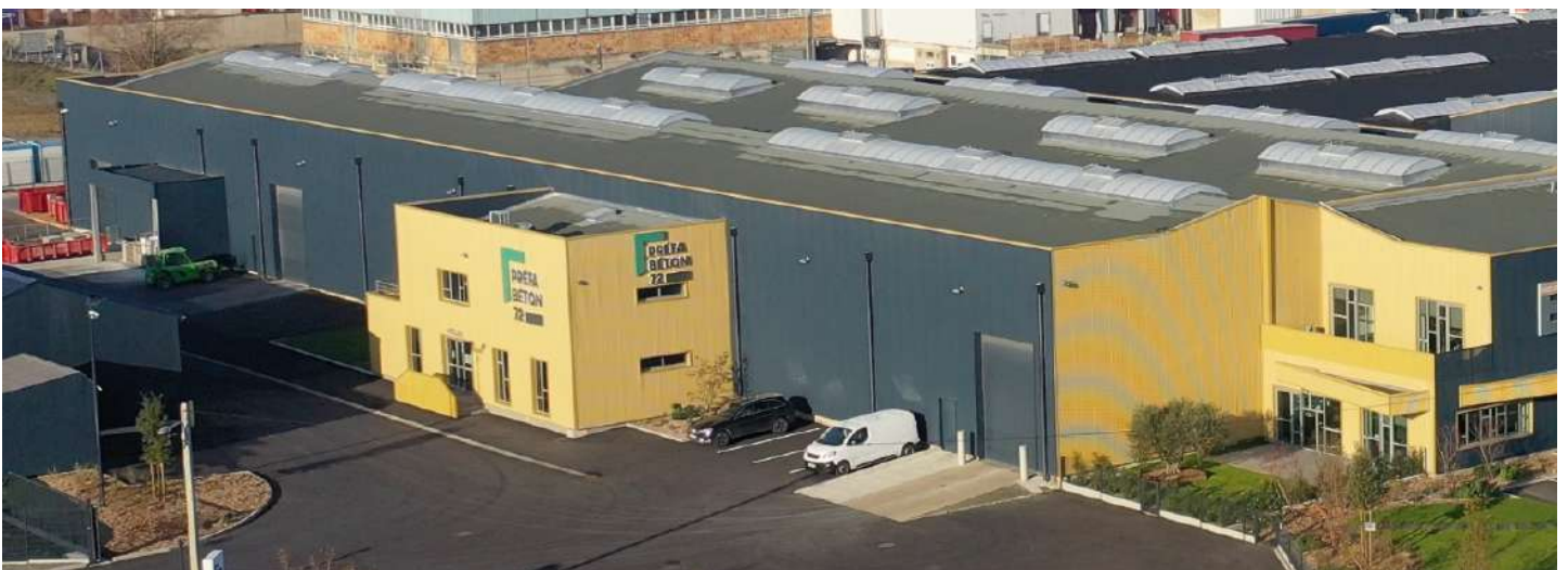
Locaux Préfa Béton 72
