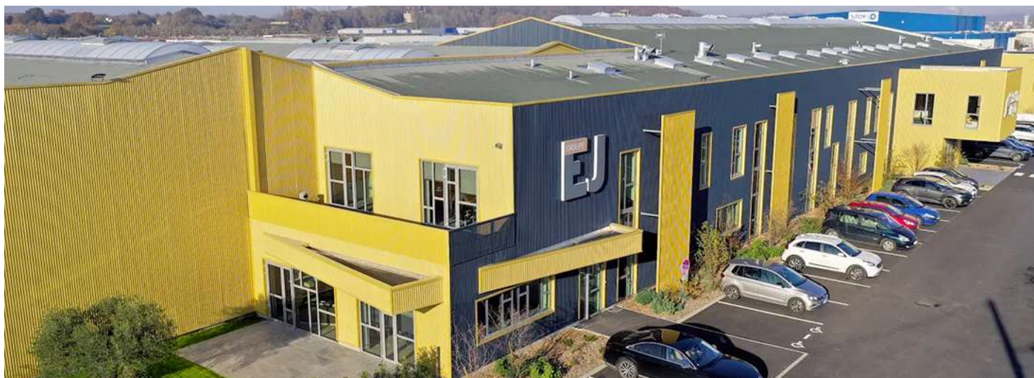
Locaux Groupe EJ, Sadrin Rapin et Préfa Béton 72
